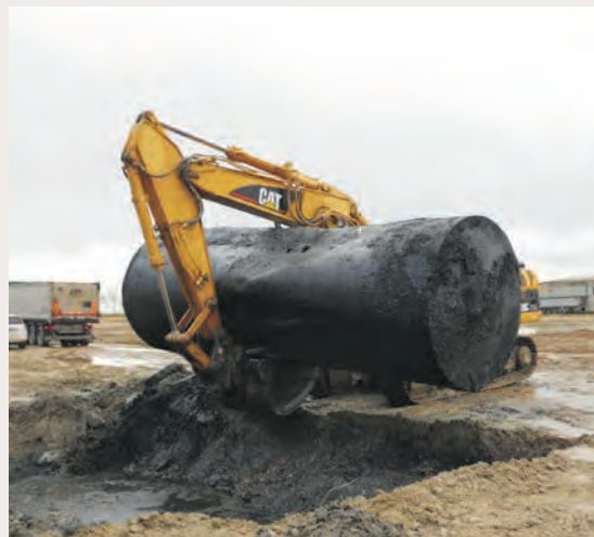
Attività di rimozione serbatoio interrato
