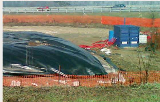
Impianto Biopila per risanamento terreni contaminati da idrocarburi
