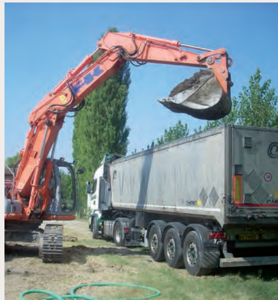
Attività di scavo e smaltimento
