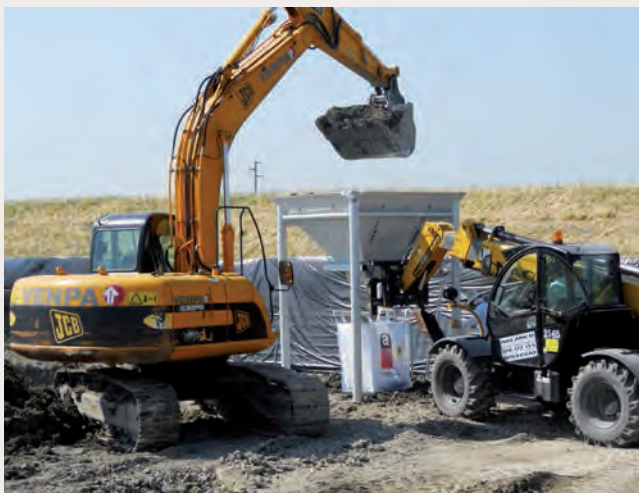
Particolare di attività di confezionamento terreno contaminato da amianto in Big Bags
