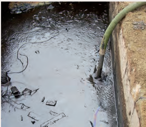
Attività di rimozione reflui residui
